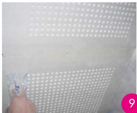
El proceso de **tratamiento de juntas** - uniones de las placas, es el **mismo proceso en cielos, paredes divisorias y revestimientos**, con placas de yeso Gyplac® convencionales. (Fig.09)
