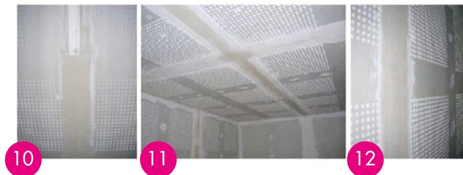
El masillado se realiza de la misma manera que en las placas de yeso Gyplac®; en este caso el **masillado no debe tener un ancho superior a 15 cm.** (Fig.10 / 11); De esta forma se logra un perfecto acabado sin ningún tipo de resalto perceptible al tacto y a la vista. En la etapa de masillado, se cubre definitivamente con una segunda capa las cabezas de los tornillos. De esta forma se obtiene una superficie lista para recibir pintura. (Fig.12)
